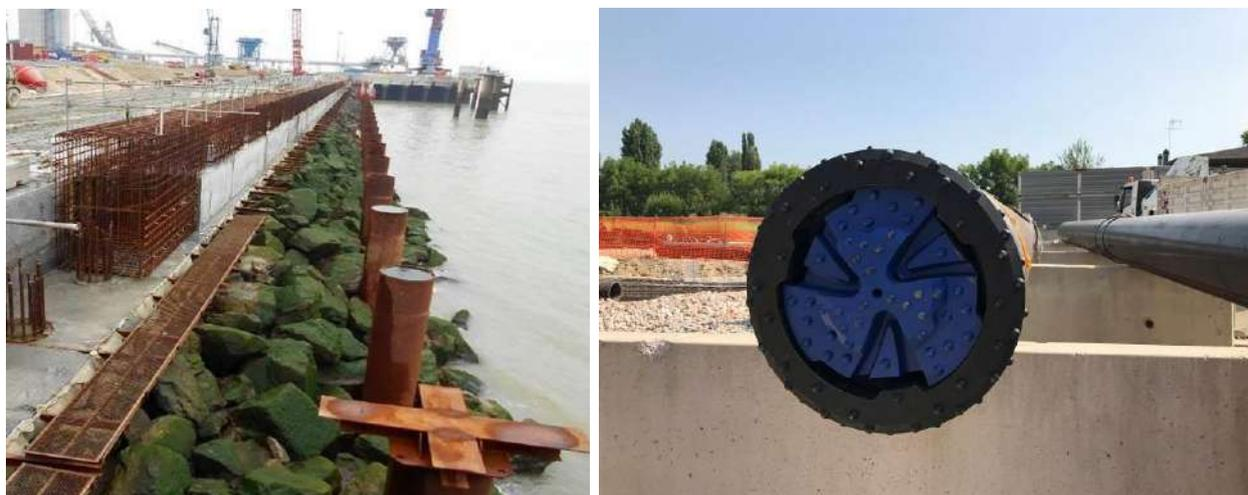
Figura 9-5: intervento su scogliera (sx); testa battente tipo DTH o similare per posa "Pipe wall" tipo O-Pile, o similare, Ø406mm (dx)
