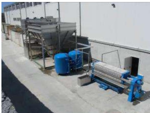
Figura 9-20: modulo di trattamento chimico - fisico
