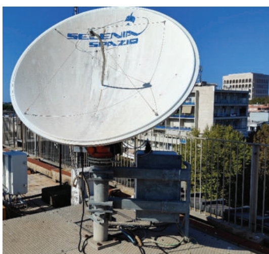
Figura 1 – Stazione ricevente Alphasat in banda Ka, dislocata presso la sede Roma EUR del MIMIT.
